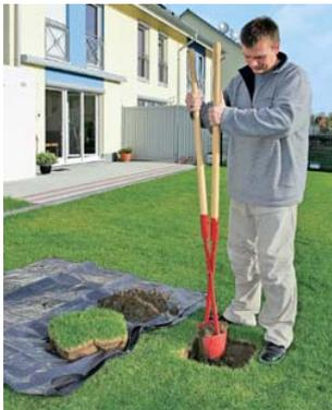
2. Dazu alle 202 cm Pfostenfundamente ausheben (30 x 30 cm, 50 cm tief). Bei intakten Rasenflächen vorher die Grassode abheben, um sie nachher wieder einzusetzen und das Betonfundament abzudecken.
