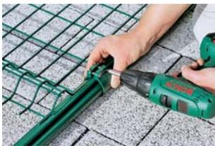
3. Erstes Gitterelement auf den Boden legen und mit den mitgelieferten Montagebügeln an zwei Pfosten befestigen. Bei der Montage beachten: Die 30 mm hohen Überstände an einer Mattenseite dürfen erst ab einer Zaunhöhe von 1,80 Metern nach oben montiert werden. Bei niedrigeren Zäunen werden die Matten umgedreht montiert, um Verletzungsgefahr zu vermeiden.
