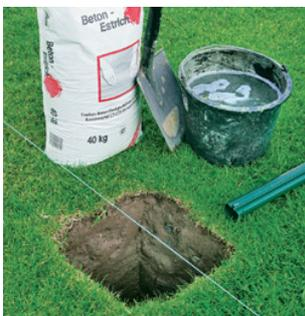
4. Beton vorbereiten und die ersten zwei Fundamente mit ca. zehn Zentimeter Beton ausgießen.
