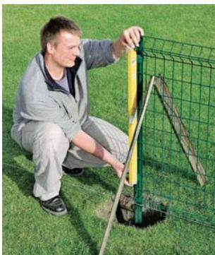
5. Die erste Gittermatte mit Pfosten einsetzen und mit Wasserwaage senk- und waagrecht ausrichten. Die Pfosten provisorisch mit Stützkonstruktion stabilisieren, z.B. mit Holzleisten.
