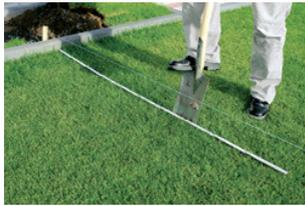
1. Den Verlauf des Zauns festlegen und diesen mit einer Richtschnur markieren. Dabei darauf achten, dass die Bodenfläche waagrecht ist. Wenn nicht, muss unter Umständen noch Erdreich aufgefüllt werden. Die Position der Pfosten analog zur Breite der Gittermatten bestimmen. Mit Hilfe spezieller Pfostensockel können die Pfosten auf Mauerwerk oder Beton montiert werden. Alternativ werden Pfostenfundamente aus Beton angelegt.
