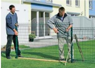
7. Entlang der waagerechten Richtschnur in der richtigen Höhe weitere Gittermatten mit Montagebügeln an den Pfosten befestigen.
