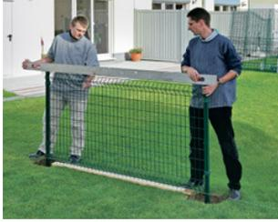
6. Fundamente mit Beton auffüllen und verdichten. Falls erforderlich Positionskorrekturen vornehmen. Tipp: Zwischen Gittermatte und Betonfundament sollte unbedingt ein Abstand von 5 cm eingehalten werden.
